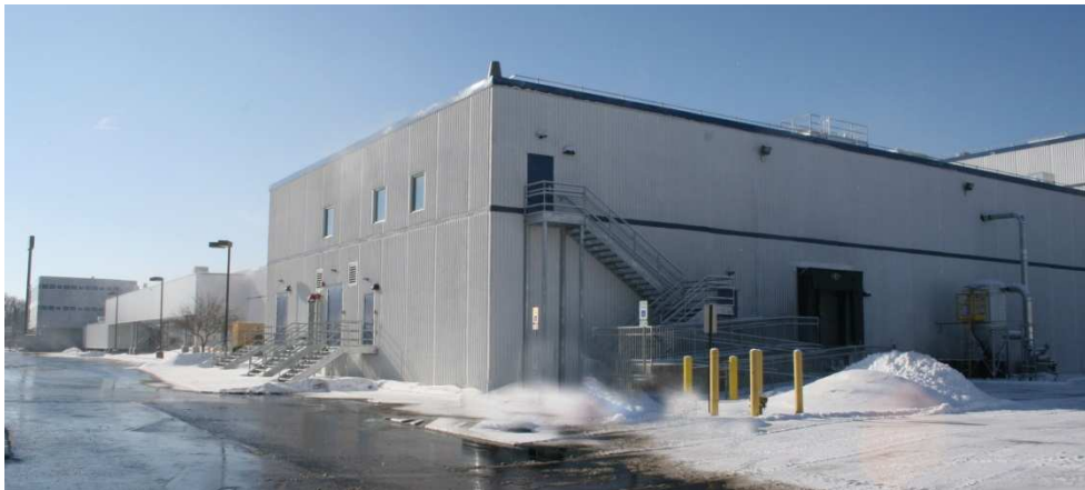
Ausbau in Chicago, USA
