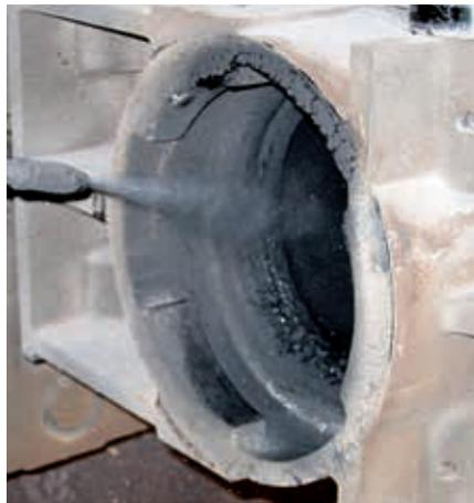
Heißsprühen, Verbindungsfläche eingebaute Schieberplatte/Ausguss
